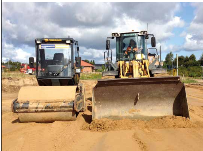
Etablering af sandpude
