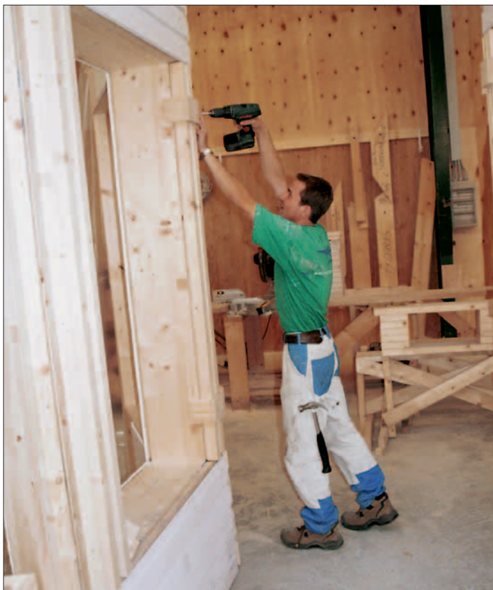
Vinduer og døre monteres i væg-elementerne.
