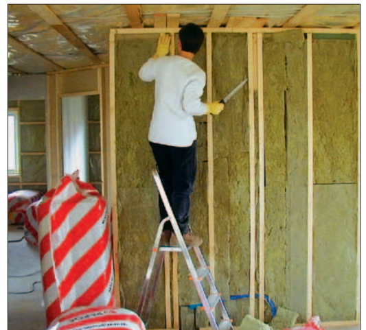
Isolering af skillevæggene er ikke det sjoveste arbejde.
