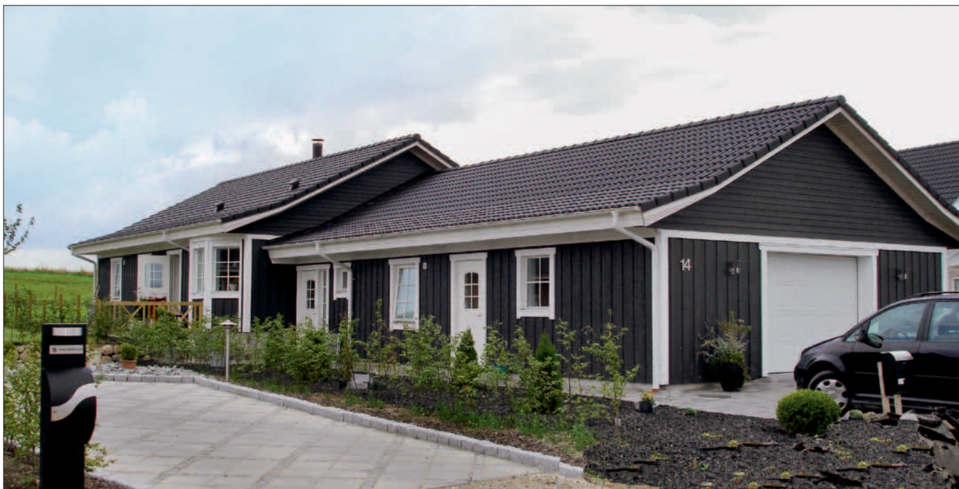
I et nyt villakvarter i Kirke Hyllinge ligger Linda og Erlings nye hus. Huset er på 184 kvm boligareal og med en dobbelt garage. Huset er niveauforskudt så det bedre følger terrænet.
